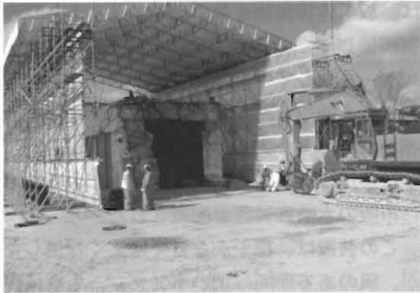
図1 北ケーブルラインにおける解体ダスト管理用エンクロージャ
