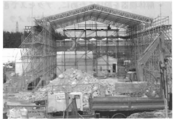
図2 北ケーブルラインの解体後にエンクロージャからシートを外した状態
